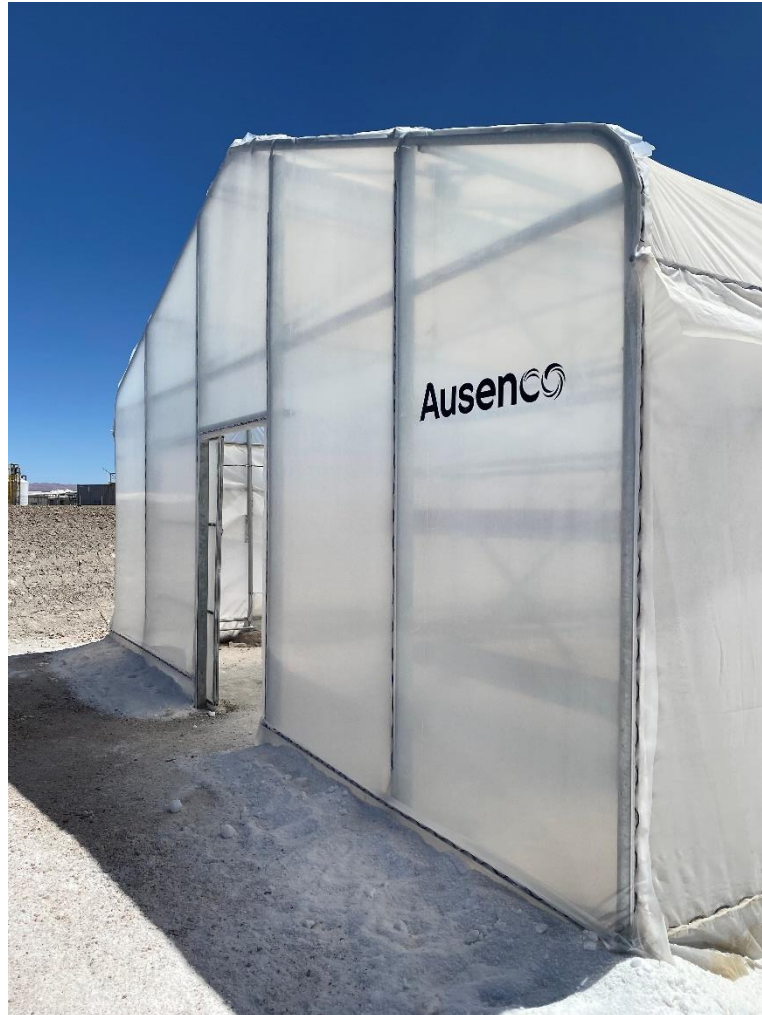
Figura 4-6: Sistema de telas o mallas coberturas
